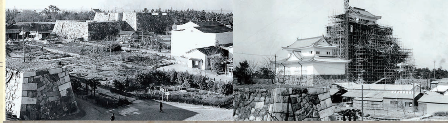
昭和20年5月の空襲で消失した名古屋城天守閣の再建工事は、昭和32年に始り昭和34年10月に全て完成した。
